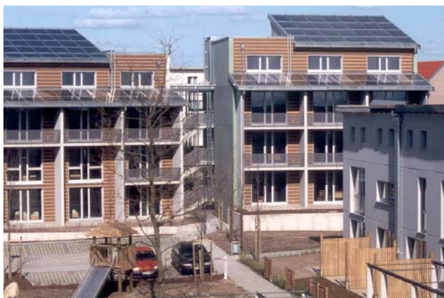
Abbildung: Solare Nahwärme in Hannover-Kronsberg
